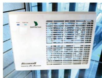
待合エリアに2カ所設置している低濃度オゾン発生装置
